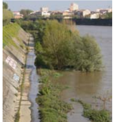
Digues dans la traversée de Toulouse
