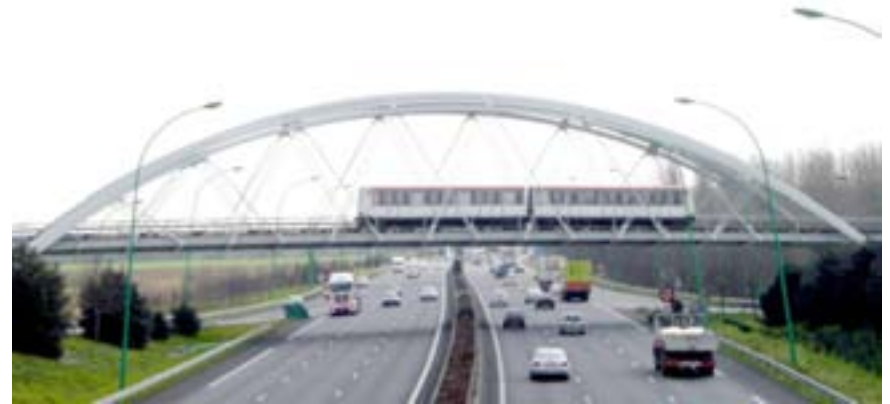
Le viaduc de franchissement de la rocade
