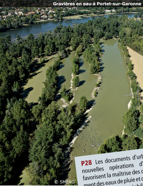
Gravières en eau à Portet-sur-Garonne
