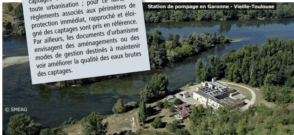
Station de pompage en Garonne - Vieille-Toulouse
