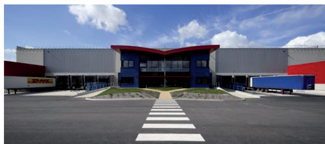
Egitra s'est implanté sur 4 600 m 2 sur le pôle logistique d'eurocentre
