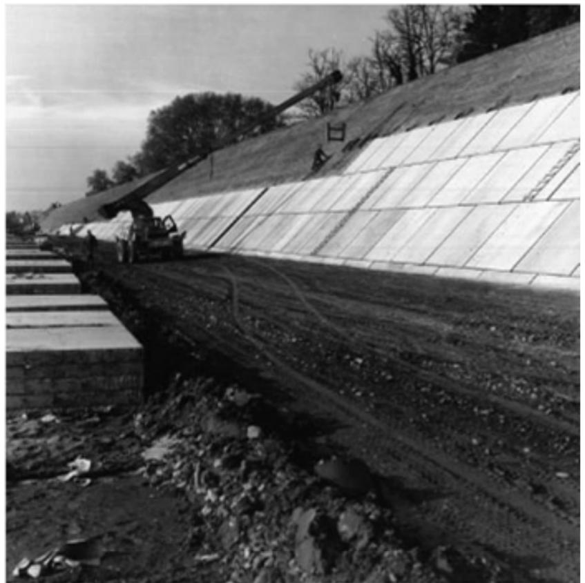
Construction de la digue des Amidonniers en novembre 1965 : pose à la grue AUSTIN des chariots d'espacements destinés à supporter les dalles, avant coulage du béton poreux
