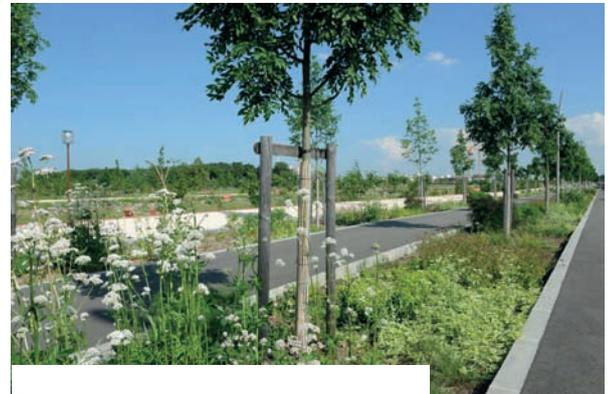
**Fossé enherbé** permettant l'infiltration naturelle des eaux pluviales – ZAC Andromède à Beauzelle et Blagnac
