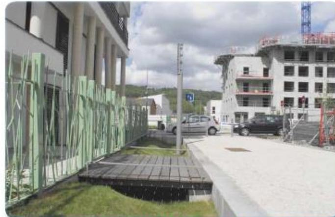
*Traitement aérien des eaux pluviales sous forme de noue engazonnée*
