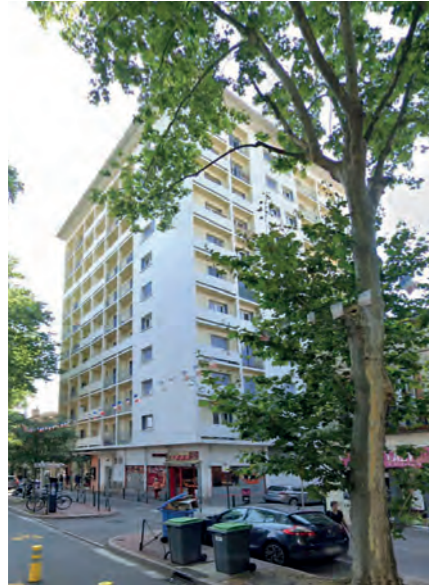
Logements, 27 avenue Étienne-Billière, construit en 1957, type d'intérêt architectural : "sans remarques particulières".
