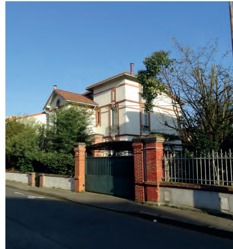
Maison de caractère de degrés 2, rue Henri Rachou
