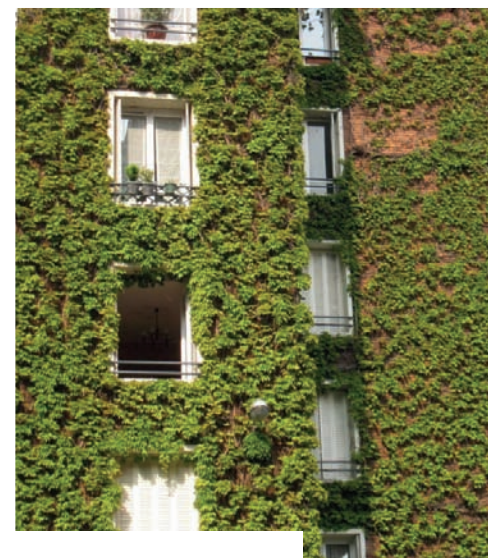
Revêtement par du lierre directement sur la façade. Paris 16 e arrondissement
