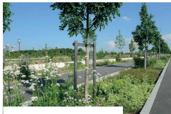
Fossé enherbé permettant l'infiltration naturelle des eaux pluviales – ZAC Andromède à Beaulieu et Blagnac Source : http://www.ecoquartier-andromede.fr
