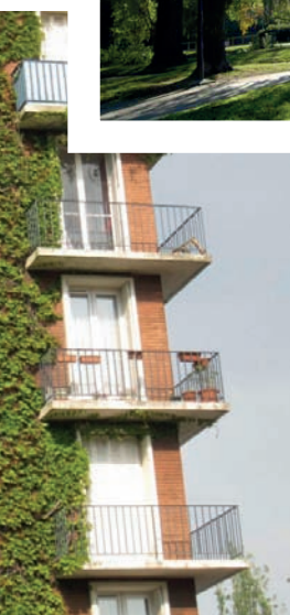
Façade constituée de plantes grimpantes enracinées au sol sur une structure à distance de la paroi. Rue Newton à Blagnac Source : Googlemaps
