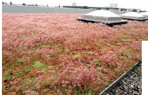
Toiture végétalisée : tapis de sedum en fleur sur le restaurant universitaire du Mirail. L'énergie du soleil est stockée par les plantes et le substrat, elle ne participe ni au réchauffement de l'atmosphère, ni à celui du bâtiment.
